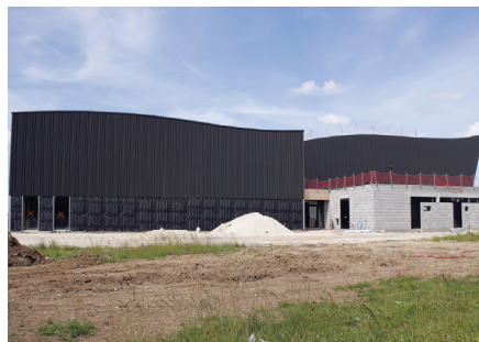
Le chantier du gymnase continue...
